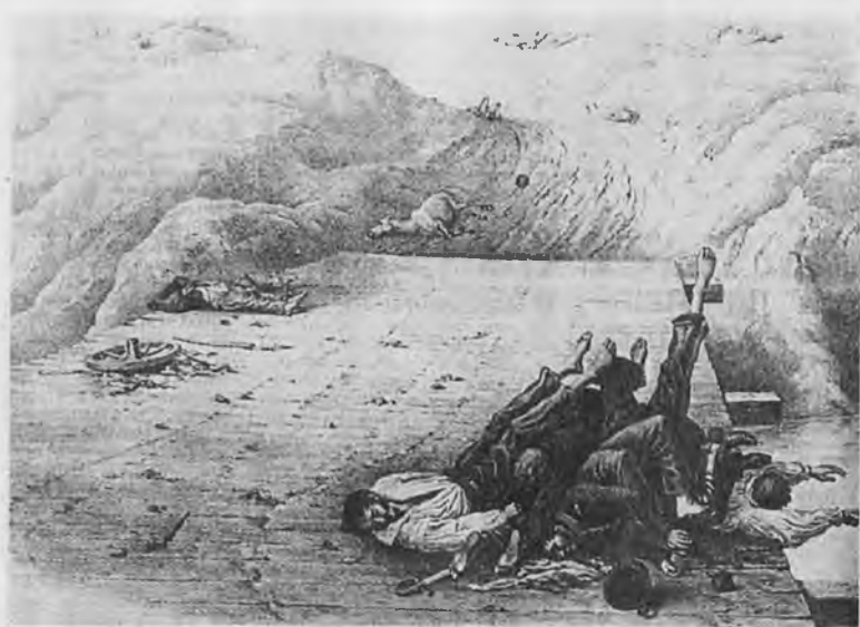
Мост через реку Колоча у села Бородино
