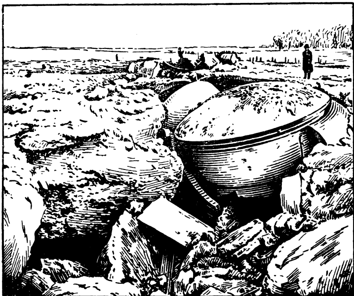
Бетонные сооружения одного из фортов Льежа, разрушенные снарядами германской тяжелой артиллерии
