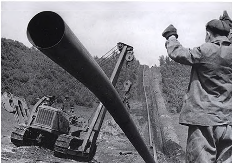
Строительство нефтепровода «Дружба» (Брянская область, 1962 г.). Нефтепровод был введен в эксплуатацию 15 октября 1964 г., а за два дня до этого, 13 октября, в результате заговора Хрущёв был снят с поста Первого секретаря ЦК КПСС. 14 октября 1964 г. этот пост занял Брежнев. Начало эксплуатации нефтепровода отодвинуло крушение Советского Союза еще как минимум на пару десятков лет и чудесным образом совпало с началом нового периода в истории СССР — периода правления Брежнева.
