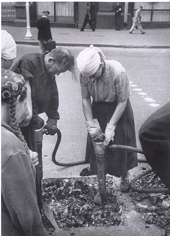
Дорожные работы (Москва, июль 1945 г.).
