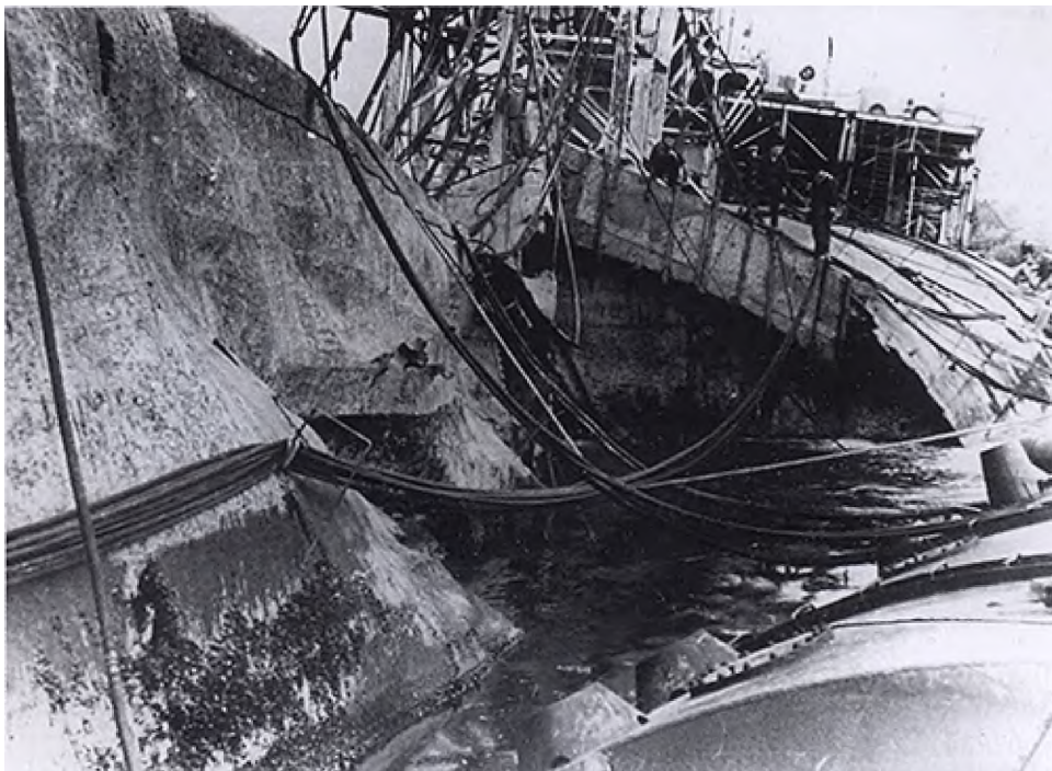
Поврежденный в результате взрыва корпус линкора «Новоросийск» после подъема (1957 г.).
