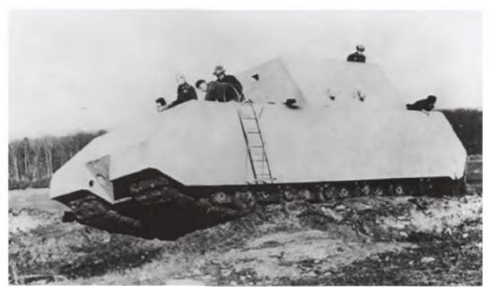
Ходовые испытания первого прототипа сверхтяжелого танка прорыва Panzerkampfwagen VIII «Maus» (1944 г., среди людей на танке — его конструктор Фердинанд Порше). Этот прототип был оснащен авиационным бензиновым двигателем «Даймлер-Бенц» МВ 509 и деревянной башней; второй недостроенный прототип имел дизельный двигатель «Даймлер-Бенц» МВ 517, который оказался капризным и ненадежным в эксплуатации.
