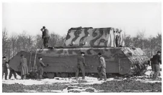
Танк вытащили; солдаты лопатами очищают налипшую на борта грязь— на снимке хорошо видно, до какого уровня танк провалился в грунт.
