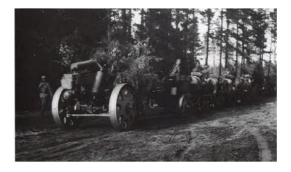
Упряжка лошадей везет 150-мм гаубицу sFH 18 со снятым орудийным стволом (Ленинградская область, лето 1941 года). Цифра 18 обозначает дату разработки и принятия на вооружение, однако она фиктивна — Версальским договором Германии была запрещена разработка артиллерийских систем, и цифру 18 орудию присвоили, чтобы ввести в заблуждение иностранные контролирующие комиссии; разработка гаубицы велась в 1926–1930 годах, в войска она начала поступать в 1934 году.
