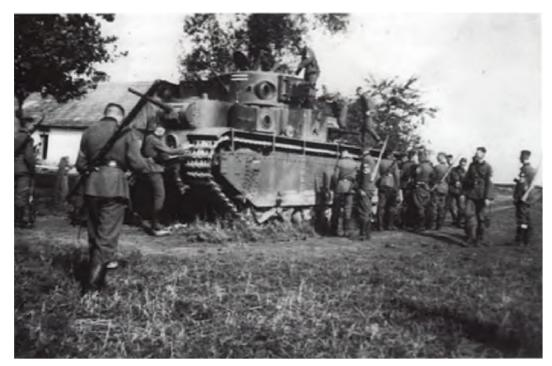
Немецкие солдаты осматривают брошенный советский танк T-35 с цилиндрической главной башней (Восточный фронт, лето 1941 г.). Главная башня T-35 была унифицирована с башней танка T-28, но танки T-35 образца 1939 года стали оснащаться конической башней.
